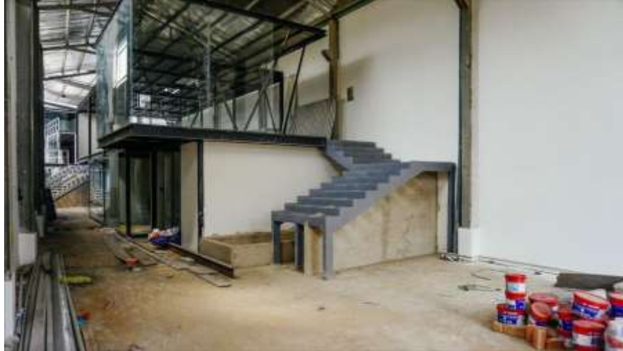
Hình 1.2 Hiện trạng xây dựng công trình
